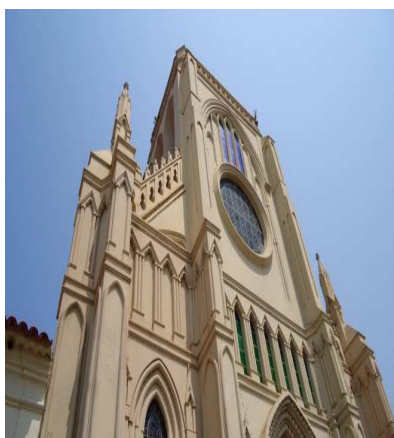
Figura 03: Igreja Nossa Senhora do Bom Despacho
